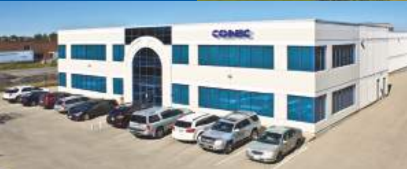
CONEC Canada, Brampton
