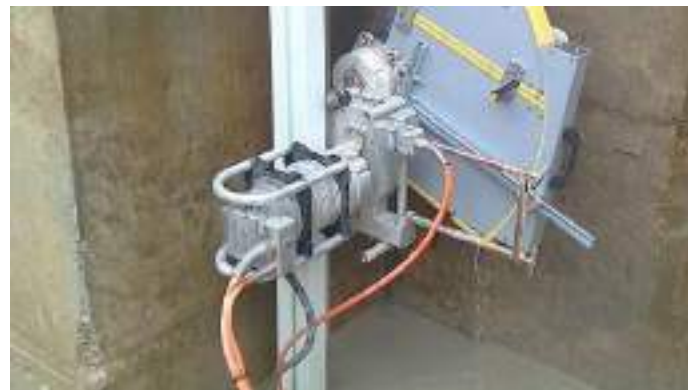
Betonsägemaschine / Concrete saw
